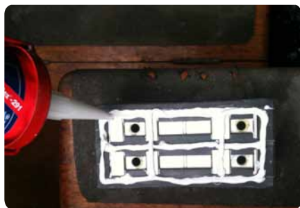
Mastic sur la base du bloqueur.
