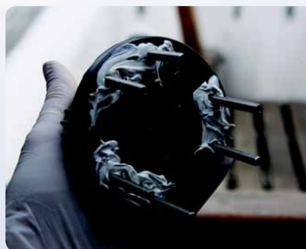
La contre-plaque fournie est placée à l'intérieur et les vis sont sécurisées par des écrous M6 indesserrables.
